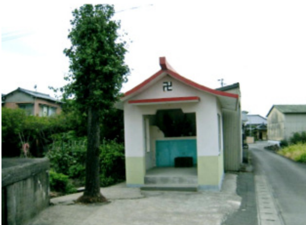
写真③ 折地地区の地蔵堂
