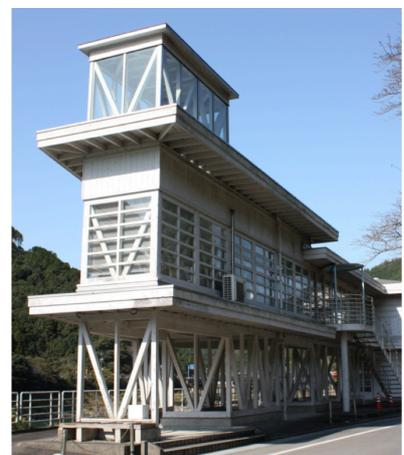
フルなポート」をデザインのコンセプトとしている。白ペンキ仕上げの外観は、ボードのクラブハウスにふさわしい力強さを表現し、周囲の自然景観とよく調和しています。1,2階ともダム湖沿いに一直線に100m近い廊下を配置して、トレーニングルーム、研修室等諸室を付加したシンプルな平面構成としている。そして、木造建築物の特徴である胴縁と筋かいを建物全体にわたって基本的な意匠コンセプトにしています。荒瀬ダムの撤去にともない平成22年4月1日をもって休館となりました。
