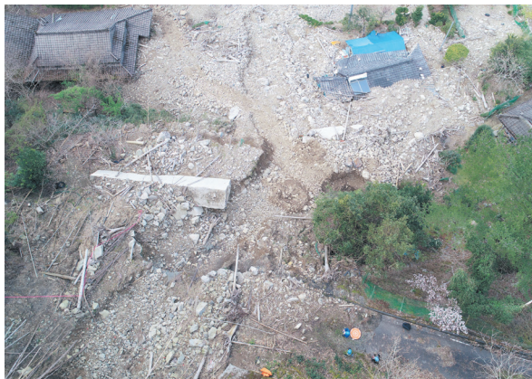
図9 市ノ俣集落の林道の倒れた擁壁（左）と被災した家屋（右上）。（ドローンで撮影）
