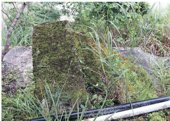
図20 遊覧船を運行していた当時の船着き場のコンクリート造階段
