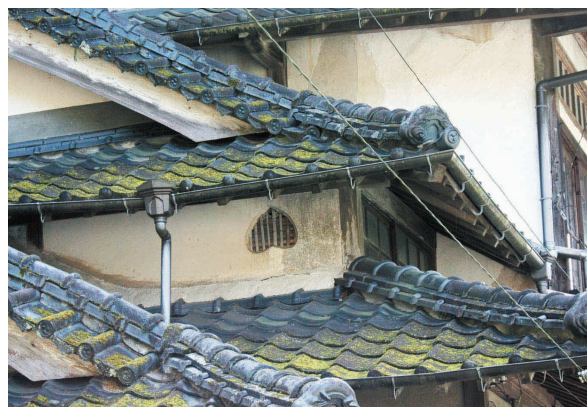
図23 2階には猪目(いのめ)の下地窓
