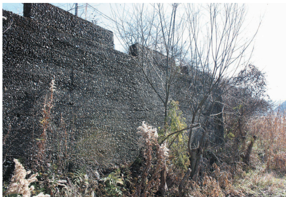
図19 ダム湖に沈んでいた土山茂商店の基礎
