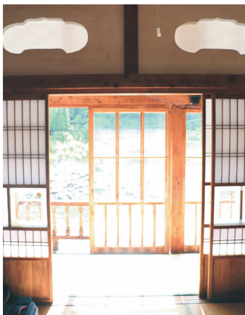
図22 居室には障子を立て、外周に縁廊下、木製窓枠の掃き出し窓、勾欄を設ける。ガラス窓を通してダム湖(建設当時)の眺望が得られた。
