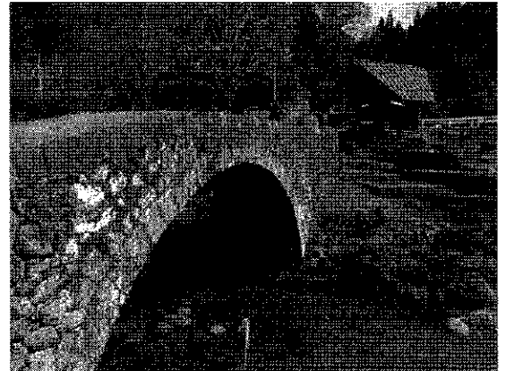
東陽町は、日本一の石工集団（種山石工）発祥の地である。東陽町ではあちこちに大小の石橋を見ることができる。
