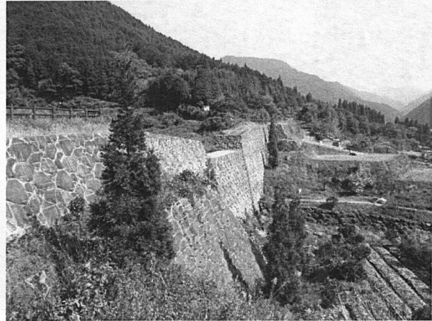
写真—5 宝川内の大規模砂防堰堤
