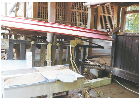
図7 大きく横ずれした中津道阿蘇神社の本殿玉垣。(2020年7月18日撮影)
