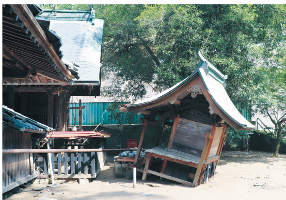
図8 被災して地面に落下した金比羅宮。(2020年7月18日撮影)
