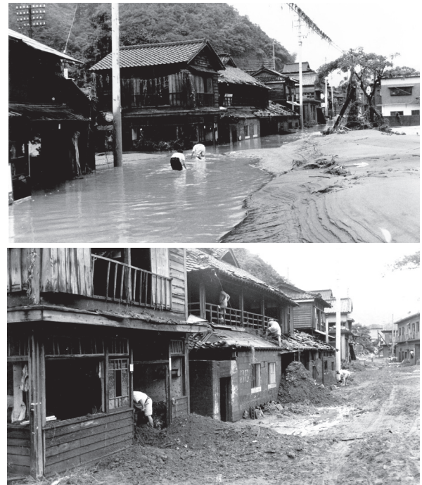
図7 坂本駅前の道路沿いの家屋の様子（上：7月3日洪水発生時午前11時頃，下：水が引いた後）
