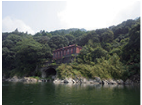
深見発電所上流
